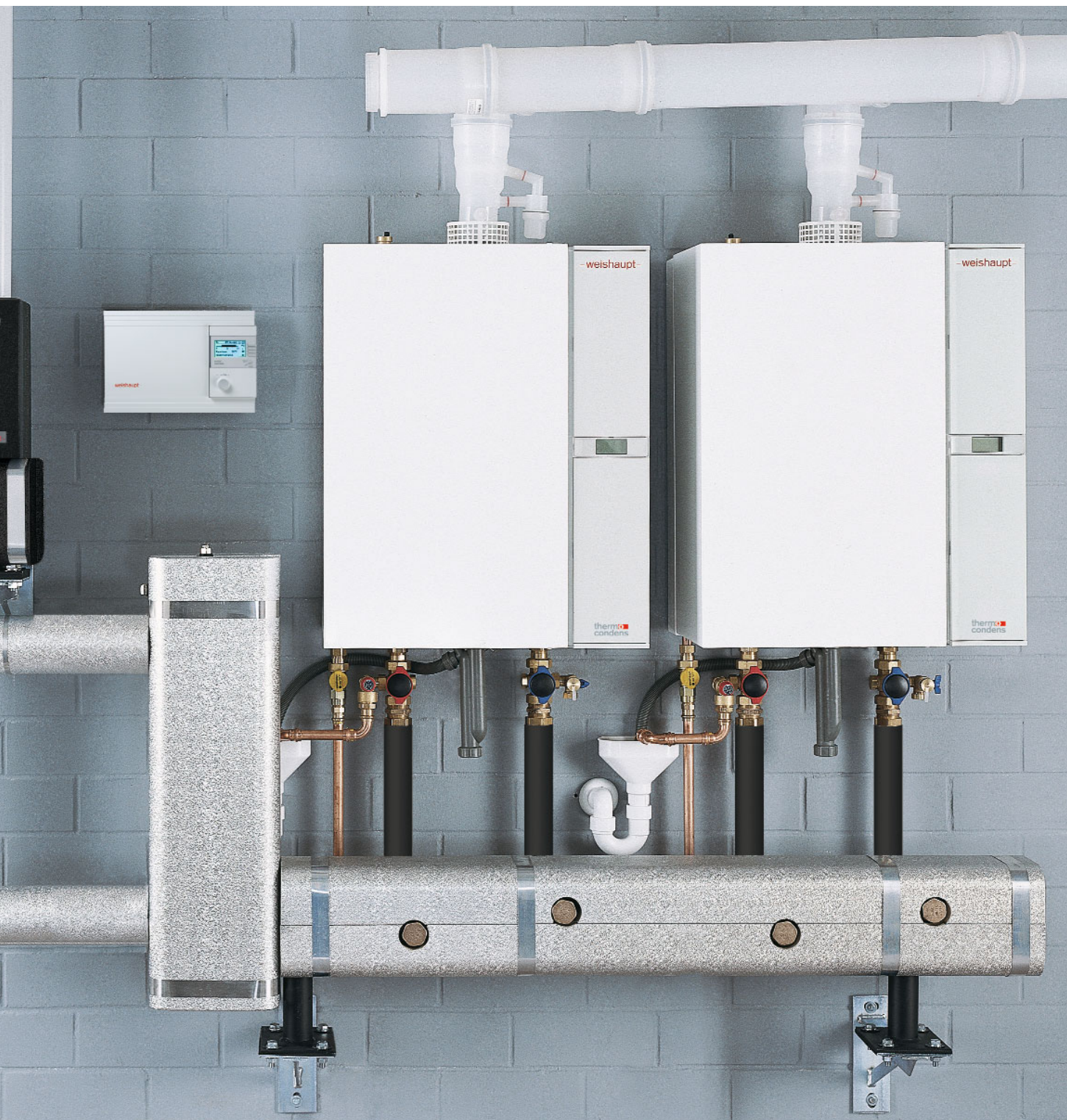
Pri kaskadi kotlov Thermo Condens z močjo 240 kW se razpon modulirane moči začne pri 5 % in se nato v odvisnosti od potreb brezstopenjsko povečuje do skupne moči
