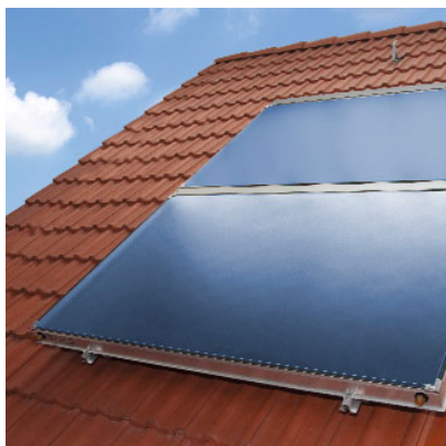
Na strešni konstrukciji
