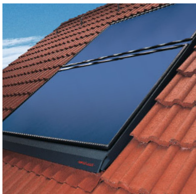
V strešni konstrukciji
