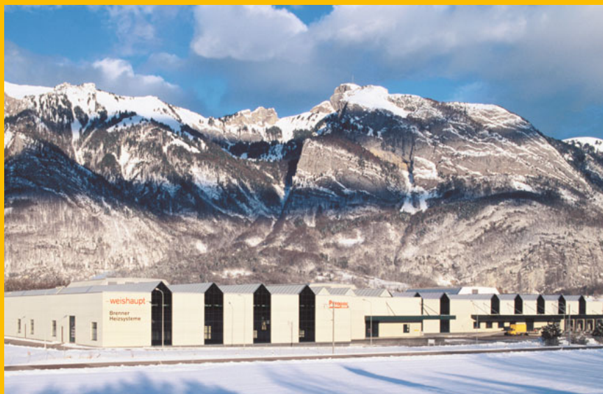
Pyropac SA, Sennwald (canton de St-Gall), usine de production pour systèmes de chauffage Weishaupt
