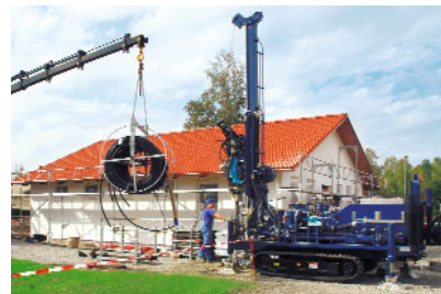
Geotermální sondy prováděné BauGrund Süd
