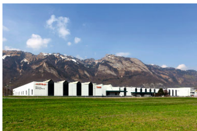
Production de chaudières à Sennwald (CH)
