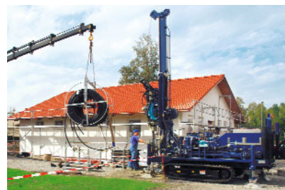
Forage de sondes géothermiques par BauGrund Süd
