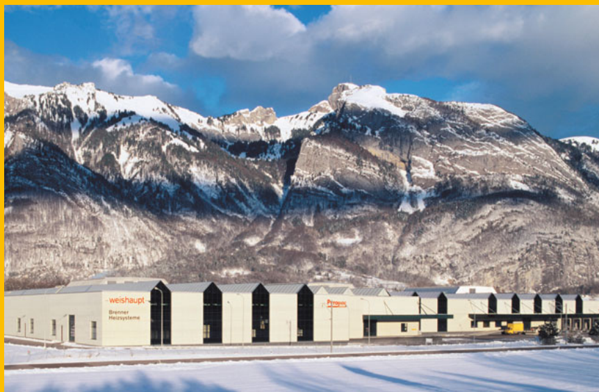
Pyropac SA, Sennwald (canton de St-Gall), usine de production pour systèmes de chauffage Weishaupt
