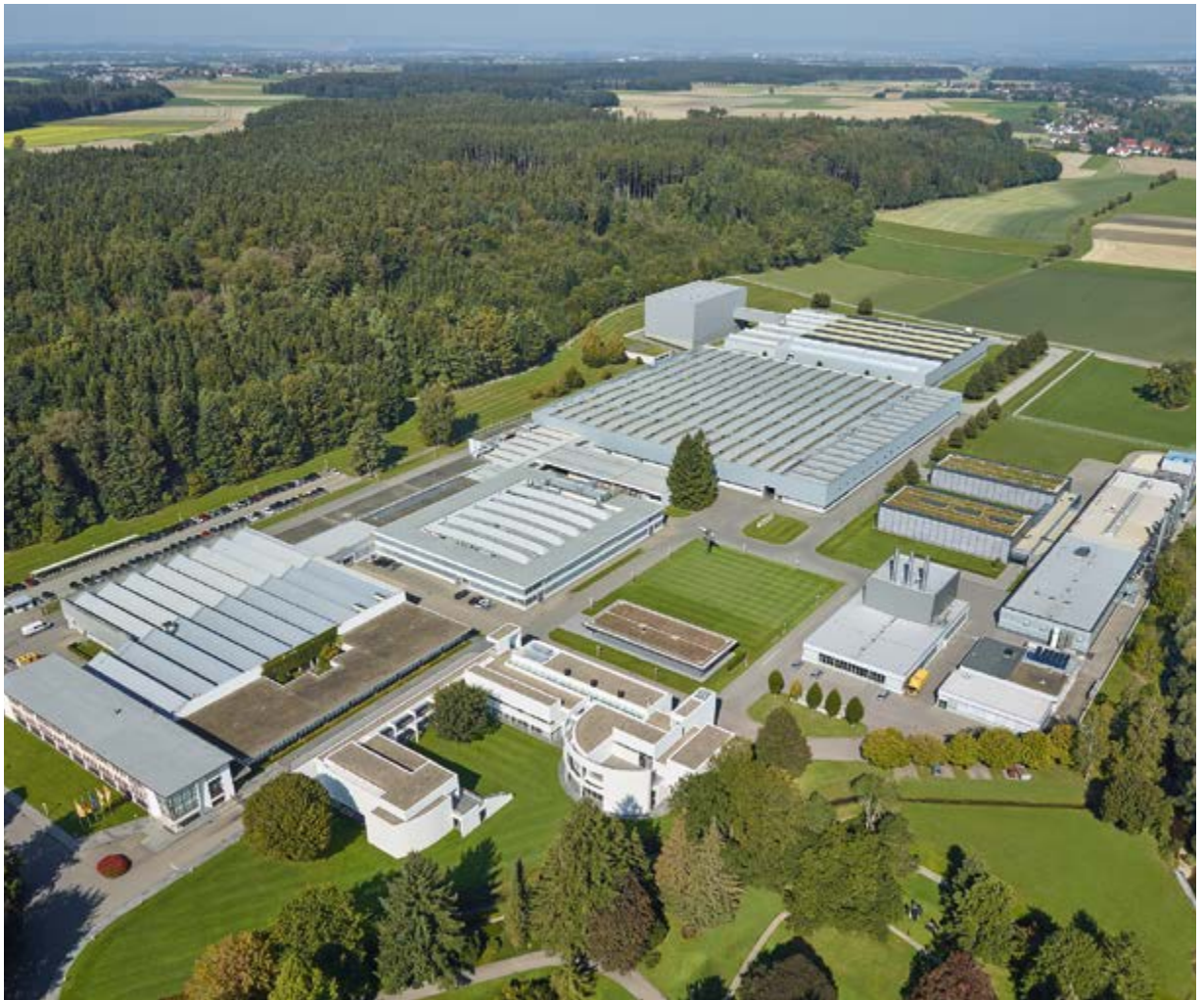
Sede e stabilimento Weishaupt a Schwendi
