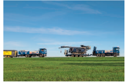
Forage de sondes géothermiques par BauGrund Süd
