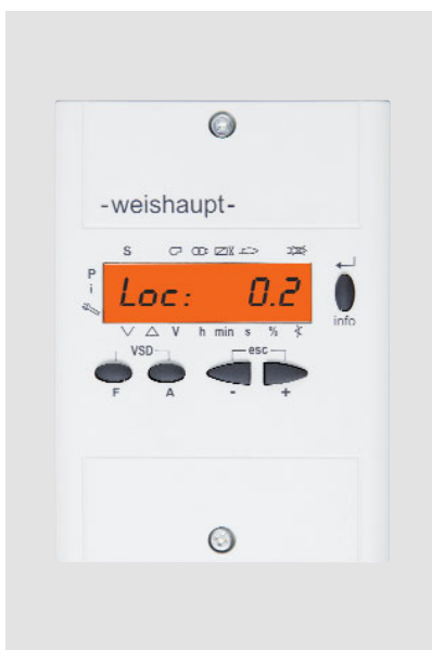
Unité de commande et d'affichage du coffret de sécurité
