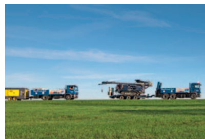
Forage de sondes géothermiques par BauGrund Süd
