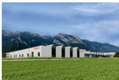
Usine de production de chaudières à Sennwald (CH)
